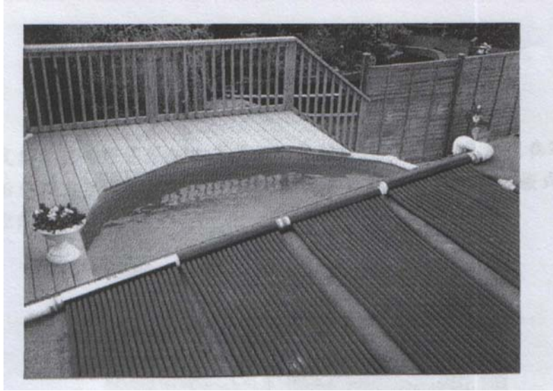
圖 4-4-3 應用於溫水游泳池之無面蓋 EPDM 式非金屬平板集熱器【5】
